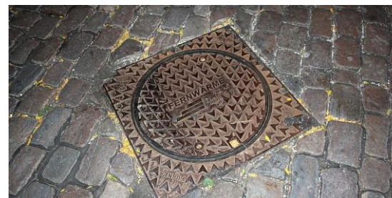
Figuur 7: Voorbeeld van putdeksel van warmtenet Stadtwerke Hamburg
