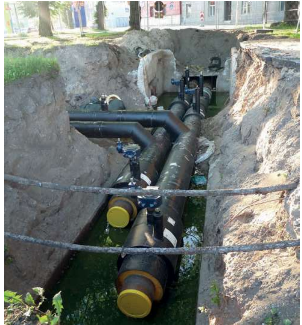
Aanleg leiding warmtenet in Tallinn, Estland (Dmitry G, Wikimedia Commons)
